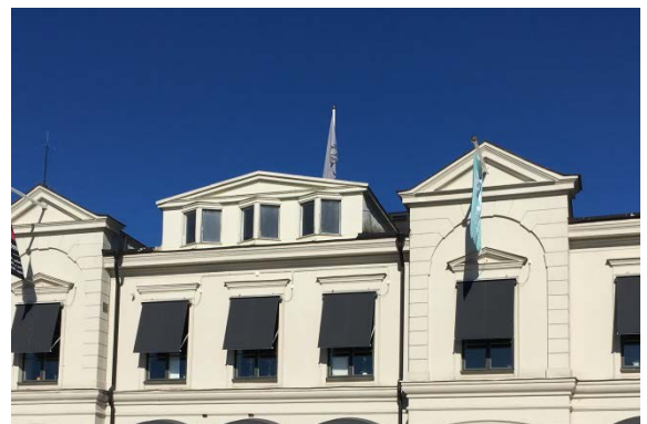
Bilden visar en av takkuporna som Tullhuset har som är vänd mot söder.
