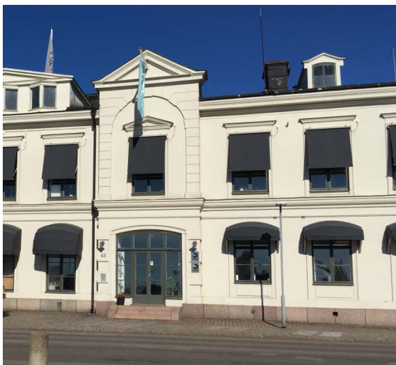
Bilden visar en av de framskjutande risaliterna på Tullhuset. En risalit är ett svagt framskjutande parti av en fasad genom byggnadens hela höjd.
