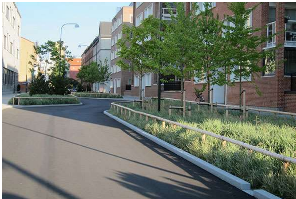
Figur 5 Nedsänkt regnbädd. Inflödet till regnbädden kan ske dels ytledes via öppningen i kantstödet, dels via ledningar till underliggande makadammagasin (Hekla Regnbädd - Bara Mineraler, 2017)
