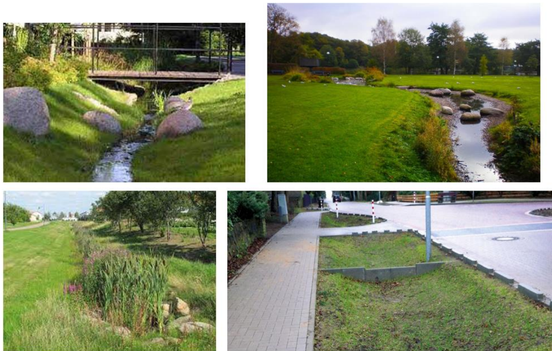
Figur 5-5. Exempel på svackdiken med mer eller mindre vatten och växtlighet i vattenfåran (Medurs från uppe till vänster: VA SYD, Mariestads kommun, Stockholm Vatten och Avfall, NSVA).
