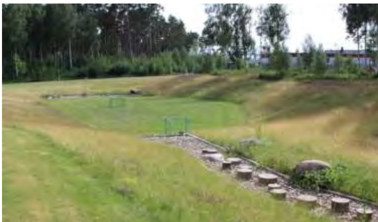
Figur 15 Exempel på gräsklädd yta för dagvattenhantering, Uranusvägen i Växjö.
