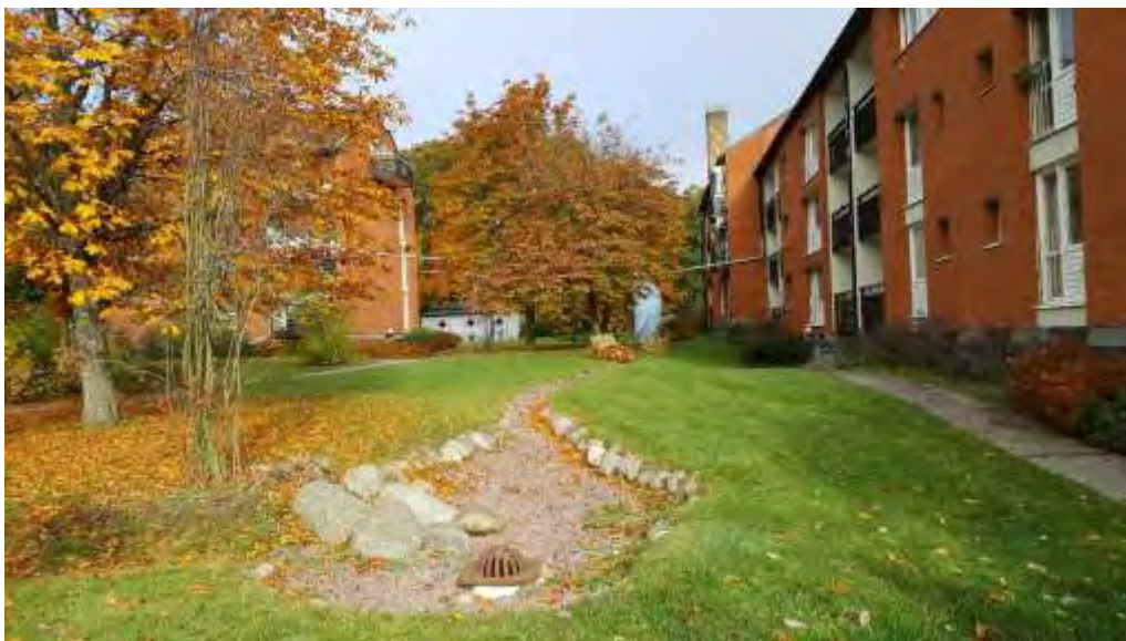
Figur 8 Exempel på grunt dike i bostadskvarter. Kv. Inspektoren, Kalmar kommun.
