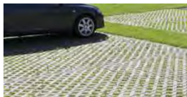
Figur 14. Exempel på gräsarmering.
