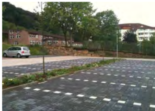
Bilden visar ett exempel på dagvattenhantering i en parkeringsyta. Källa: Uppsala Vatten
