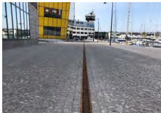
Bilden visar ett exempel på dagvattenränna för linjeavvattning vid Linnéuniversitetet i Kalmar
