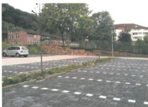
Bilden visar ett exempel på dagvattenhantering i en parkeringsyta. Källa: Uppsala Vatten
