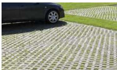
Figur 10. Gräsarmering. Foto Benders
