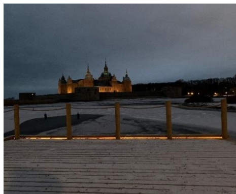
Diskret belysning som ej stör vyn mot slottet.
