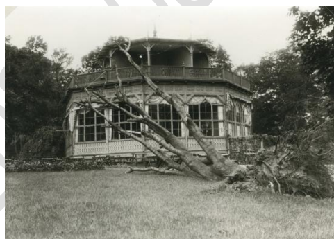
Stormen 1931, omkull fallet träd framför Byttan.
