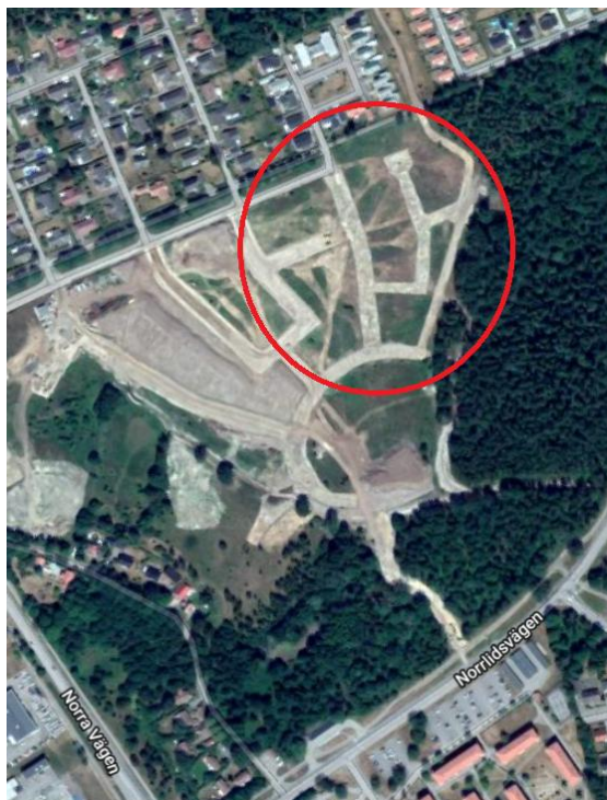
Figur 1: Aktuellt område för geoteknisk undersökning (Google Maps).
