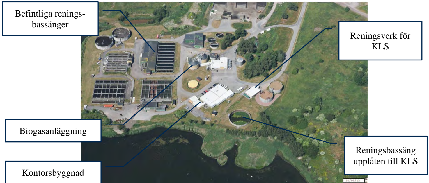
Snedbild över nuvarande reningsverk
