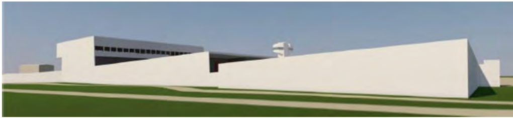
Figur 13 Idéskiss för utformning av nytt reningsverk, vy från Vesholmsvägen (Staffan Strindberg ark SAR/MSA)
