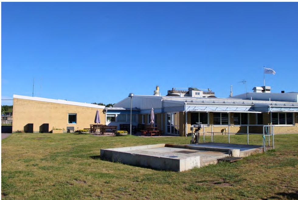
Kontorsbyggnad för Kalmar Vatten AB
