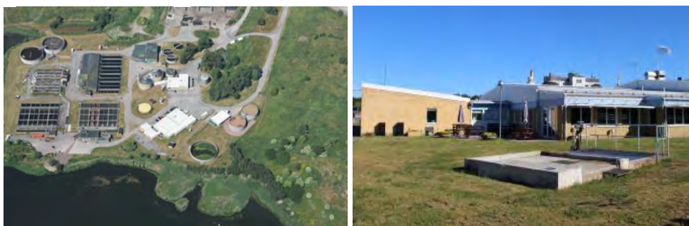
Figur 2 Vänstra bilden visar befintligt reningsverk. Högra bilden visar Kalmar Vatten AB:s kontorsbyggnad intill reningsverket. Foto: Kalmar kommun.
