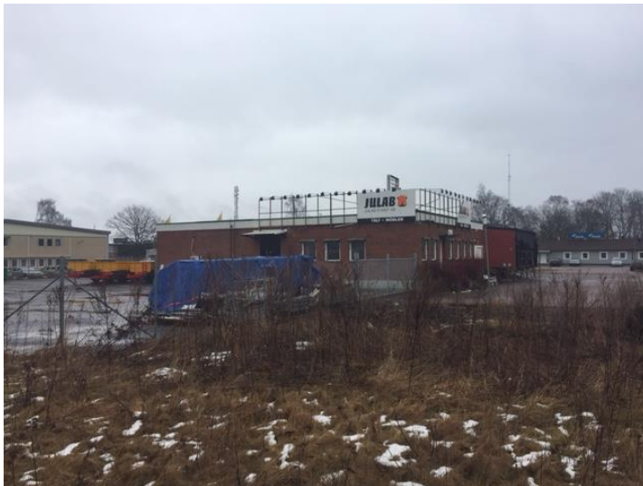
Figur 2.4 Områdesbild. Byggnation på Kv. Pantern 7.
