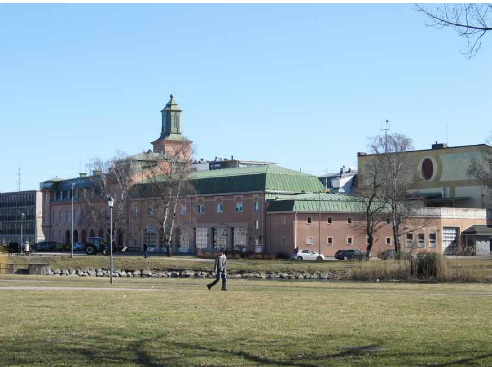
Kalmar brandstation i mars 2012.
