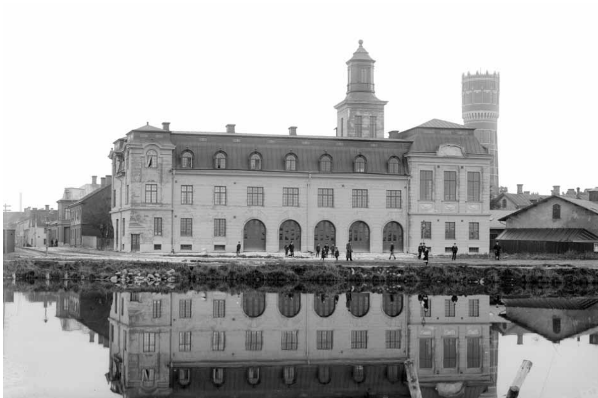
Den nyuppförda brandstationen år 1909. (GB143, Kalmar kommuns bildarkiv)
