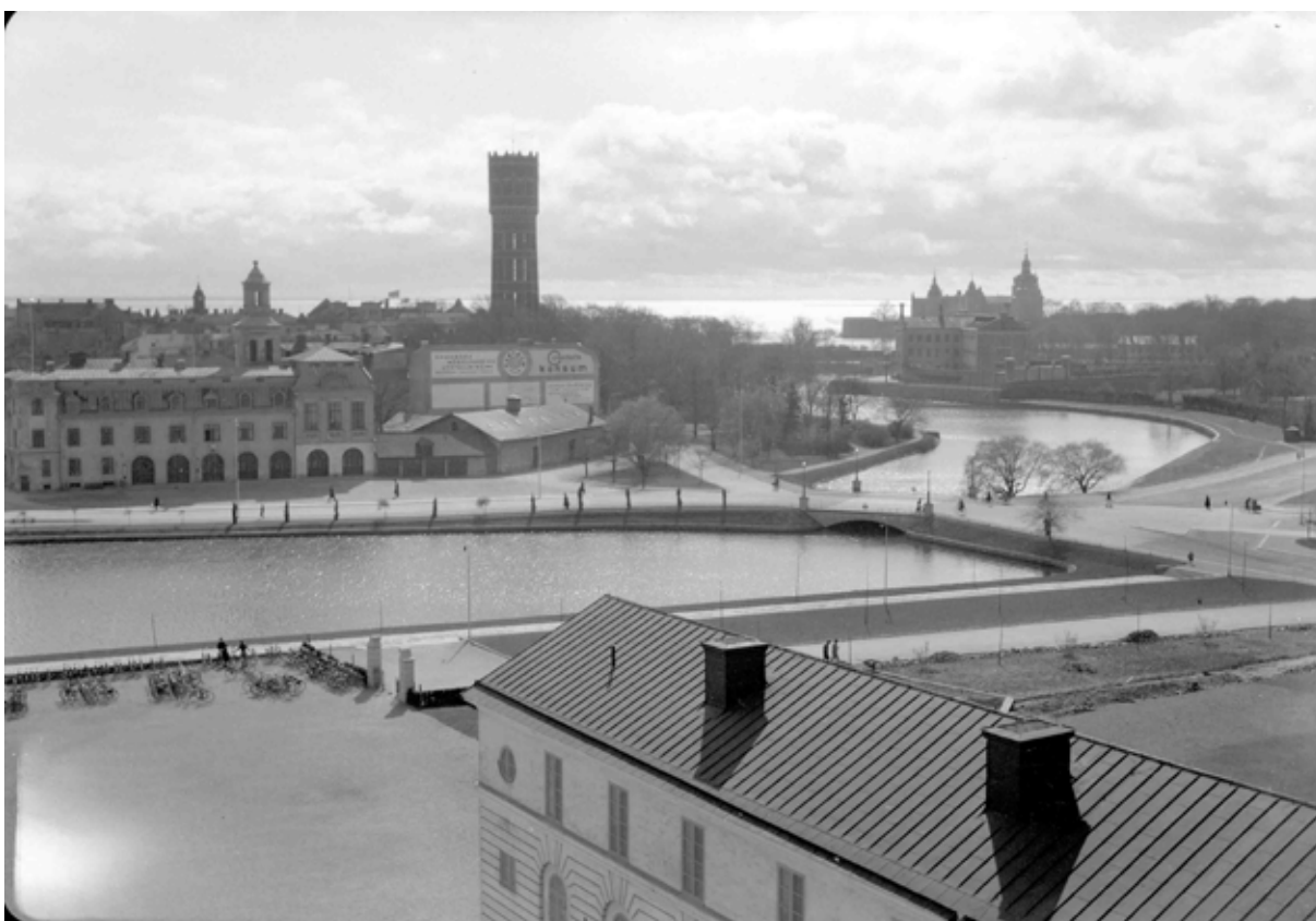
Foto från den relativt nyuppförda Stagneliuskolan över brandstationen på Kvarnholmen och Sveaplan. Fotot är taget 1938 och visar att brandstationen var sammanbyggd med förrådsbyggnaden på hörntomten. (nd122, Kalmar kommuns bildarkiv)
