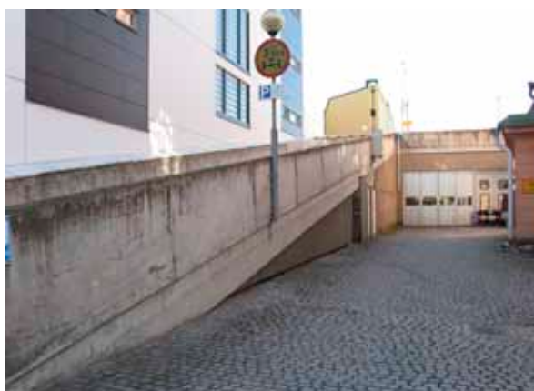
Bilrampen leder österifrån upp till parkeringsdäcket bakom brandstationen.
