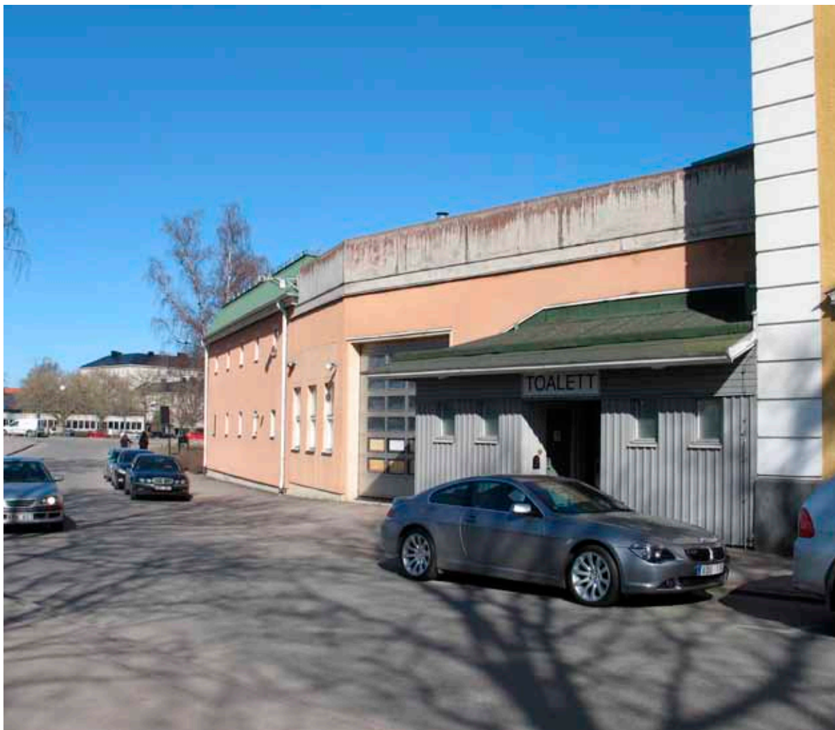
Den del av brandstationen som vetter mot Larmgatan, med skyddsrum och verkstad i bottenvåningen och parkeringsdäck på gården mellan huskropparna.
