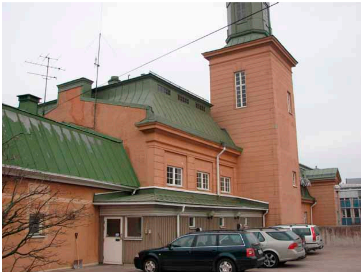
Södra fasaden sedd från parkeringsdäcket i söder. Mitt på bilden ses den förbindelsegång mellan den gamla och nya delen som tillkom vid ombyggnaden på 1980-talet.
