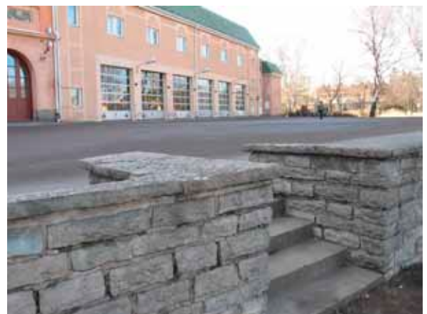
Den lilla muren i kalksten ramar in området framför brandstationen och skiljer det från trottoaren. Muren har uppförts med hög kvalitet och tillför en positiv känsla till utemiljön.
