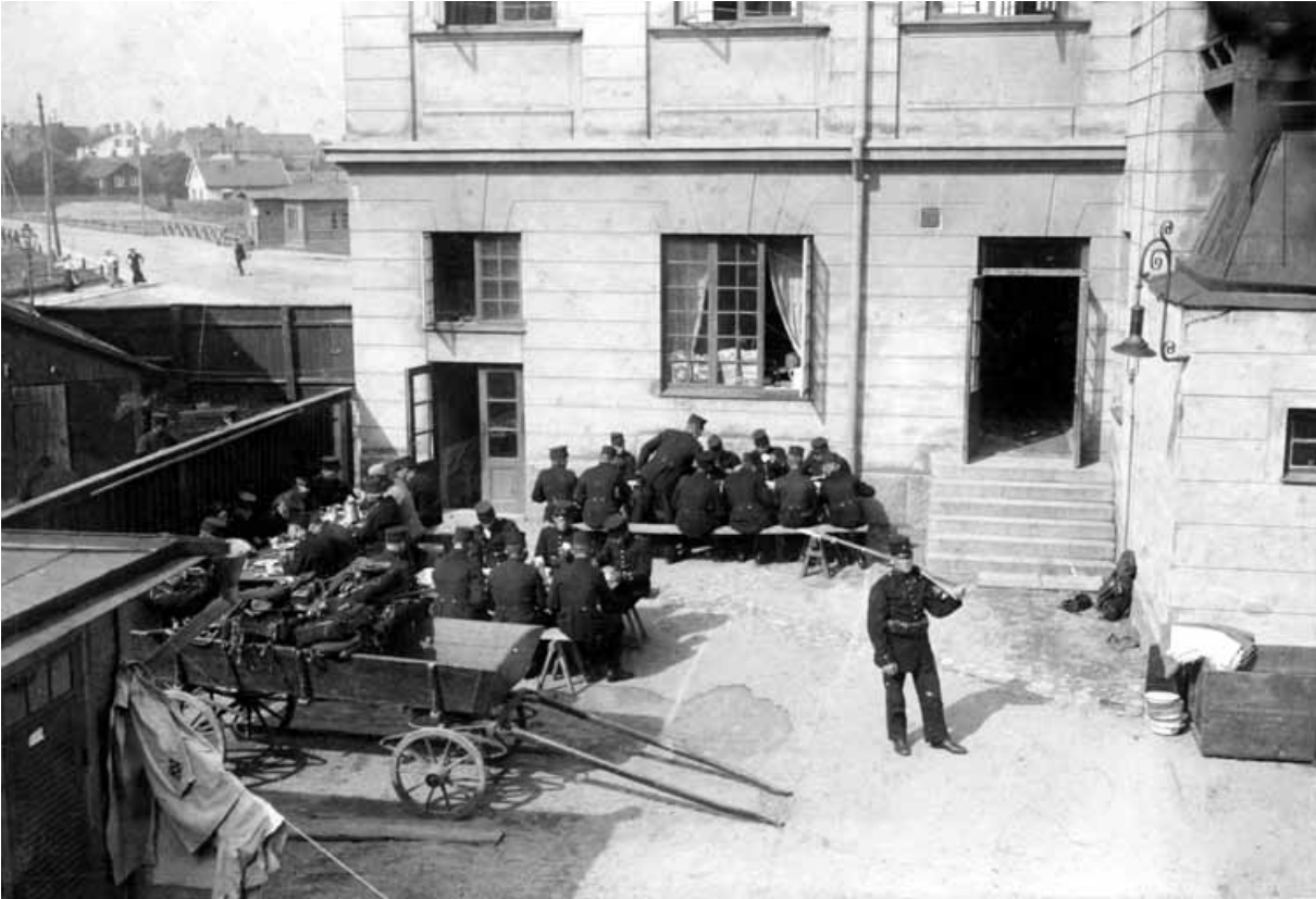
Matrast på bakgården år 1910. Den högra dörren ledde in till manskapets kök och matsal och den vänstra till en handkammare. Denna del av fasaden är idag förbyggd. (KLM A25746)
