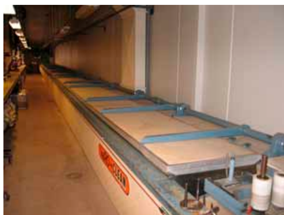
Utrymmet under rampen rymmer den moderna slangtvätt- och torken.
