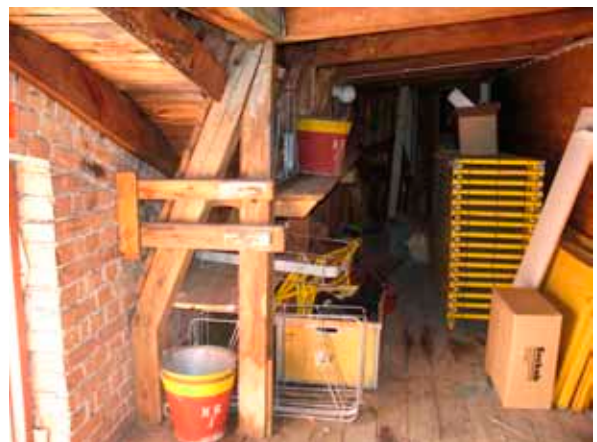
Förrådsutrymmet över det f.d. stallet som ursprungligen användes som höloft.
