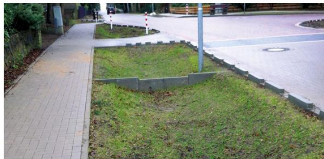
Figur 5-5. Exempel på svackdiken med mer eller mindre vatten och växtlighet i vattenfåran (Medurs från uppe till vänster: VA SYD, Mariestads kommun, Stockholm Vatten och Avfall, NSVA).
