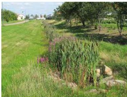
Figur 5-5. Exempel på svackdiken med mer eller mindre vatten och växtlighet i vattenfåran (Medurs från uppe till vänster: VA SYD, Mariestads kommun, Stockholm Vatten och Avfall, NSVA).
