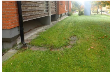
Figur 13 avledning till gräsyta och lågstråk för infiltration
