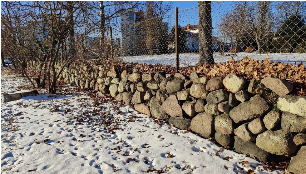
Stenmur i södra planområdet i fastighetsgräns mellan Svalan 20 och Malmen 2:2.
