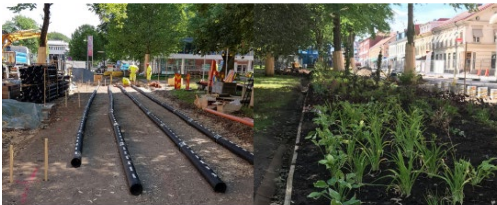
Figur 7 Exempel på rör för bevattning
