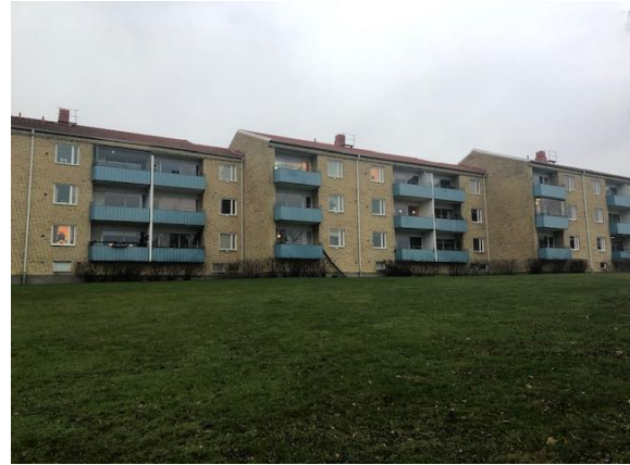
Bild 2.4 Befintlig bebyggelse på Kv. Bergkristallen 1.
