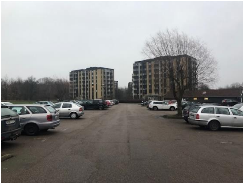
Bild 2.3 Befintlig bebyggelse på Kv. Bergkristallen 2.
