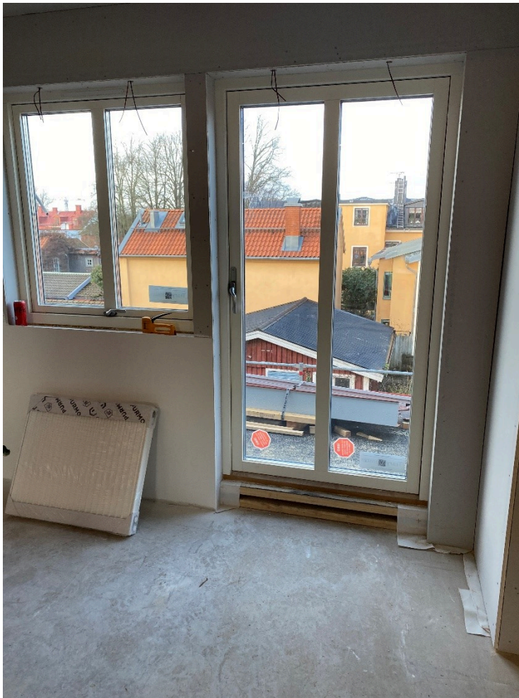
Invändigt takkupa mot gård.
