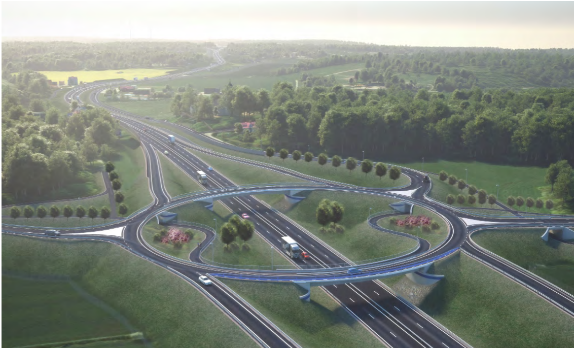
Förslag B som tagits fram i samband med ÅVS 2021, visar en större cirkulationsplats med planskild korsning för att uppnå hög trafiksäkerhet för gående och cyklister. Inspirationsbild av ombyggd trafikplats som byggs vid Lösen, Karlskrona kommun, källa: Trafikverket, 2018.
