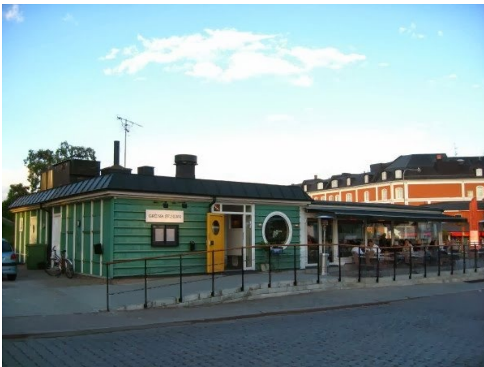
Restaurangbyggnaden på den berörda fastigheten.
