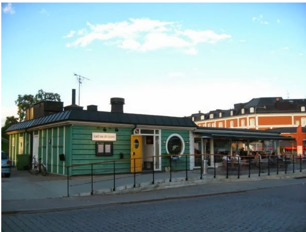
Restaurangbyggnaden på den berörda fastigheten.
