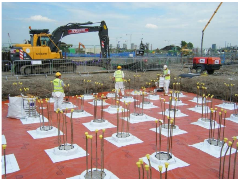
Figur 4. Tät grundläggning i kombination med pålning.
