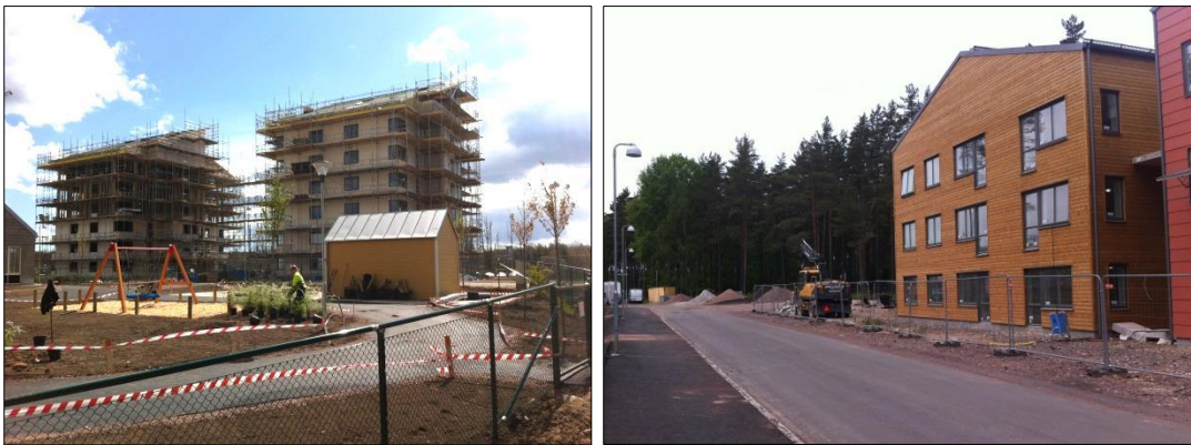
Figur 13: Foton som visar pågående byggnationer vid bostadsområdet Snurrom etapp 1, öster om planområdet, sommaren 2018.
