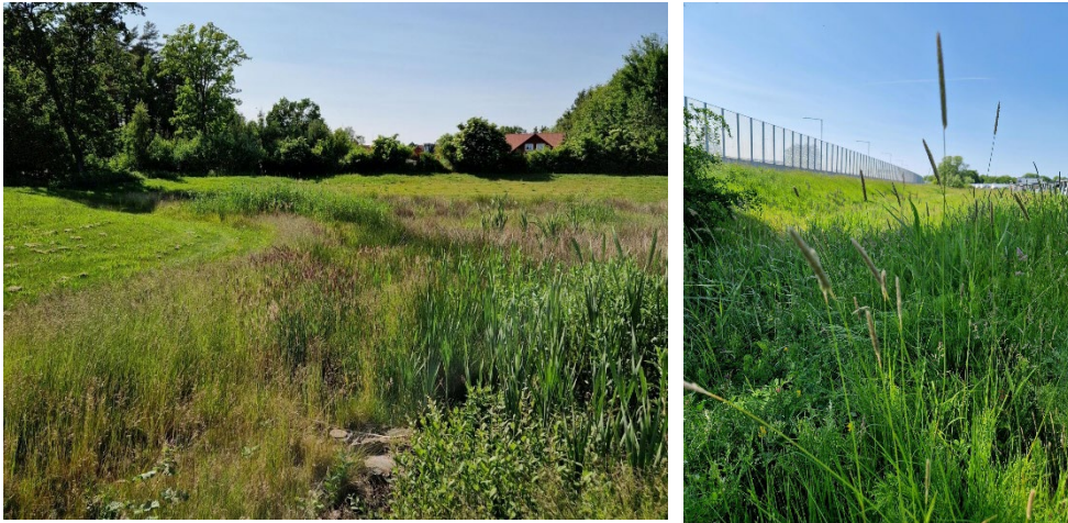
Bilderna visar en dagvattendamm och ett dagvattendike och illustrerar hur vegetationen i en dagvattenanläggning kan se ut.
