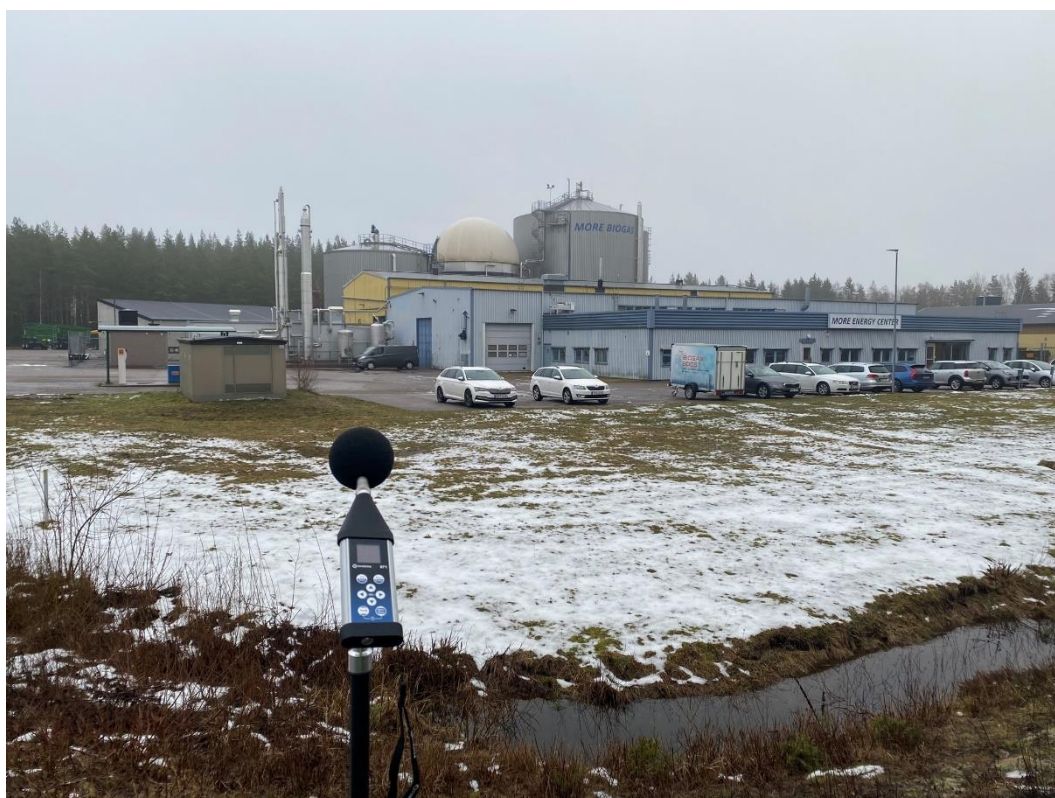
Figur 1. Fotografi, biogasanläggning från platsbesök 2024-02-14.
