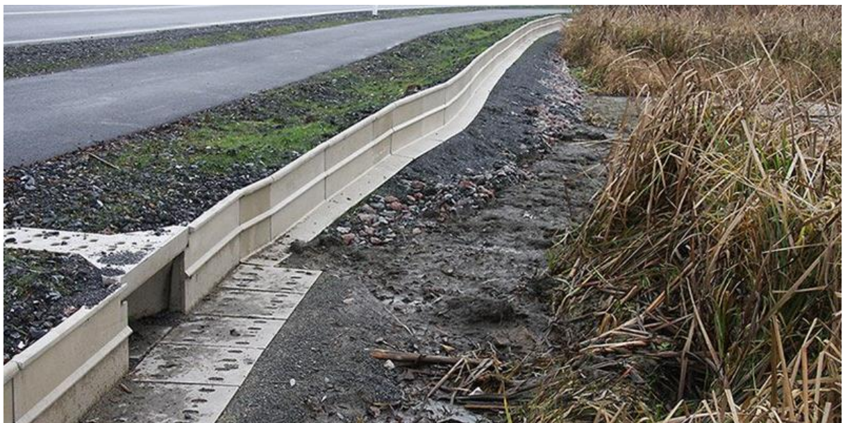
Figur 9. Exempel på faunapassage med ledarmar anpassad för groddjur (ACO Wildlife).
