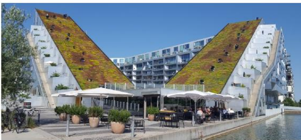
Figur 15. Sedumtak på SHouse Vestamager, i utkanten av Köpenhamn.
