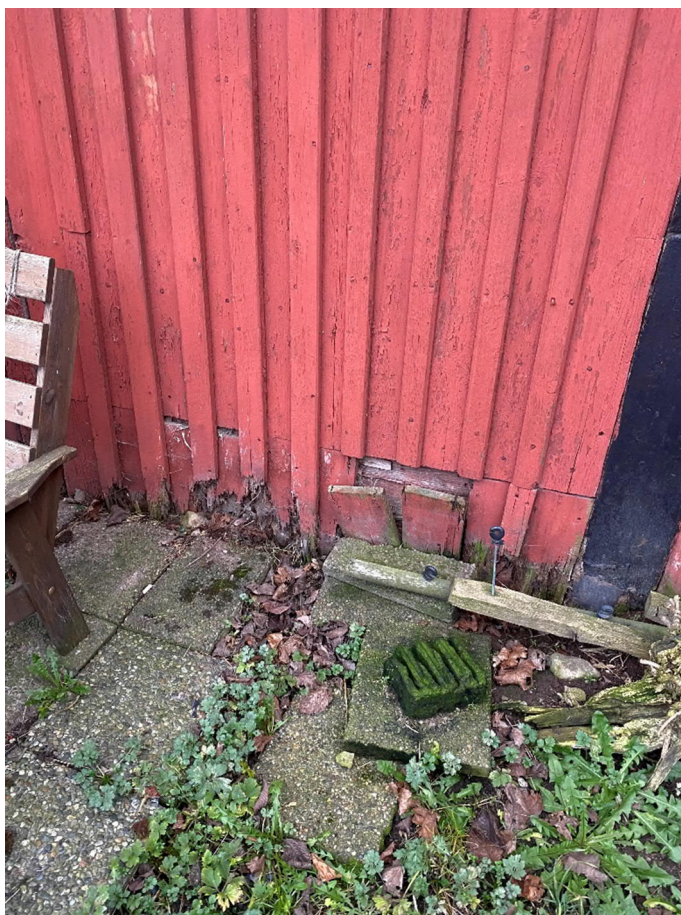
Bild 4 – Byggnad 1, fasad mot norr.
