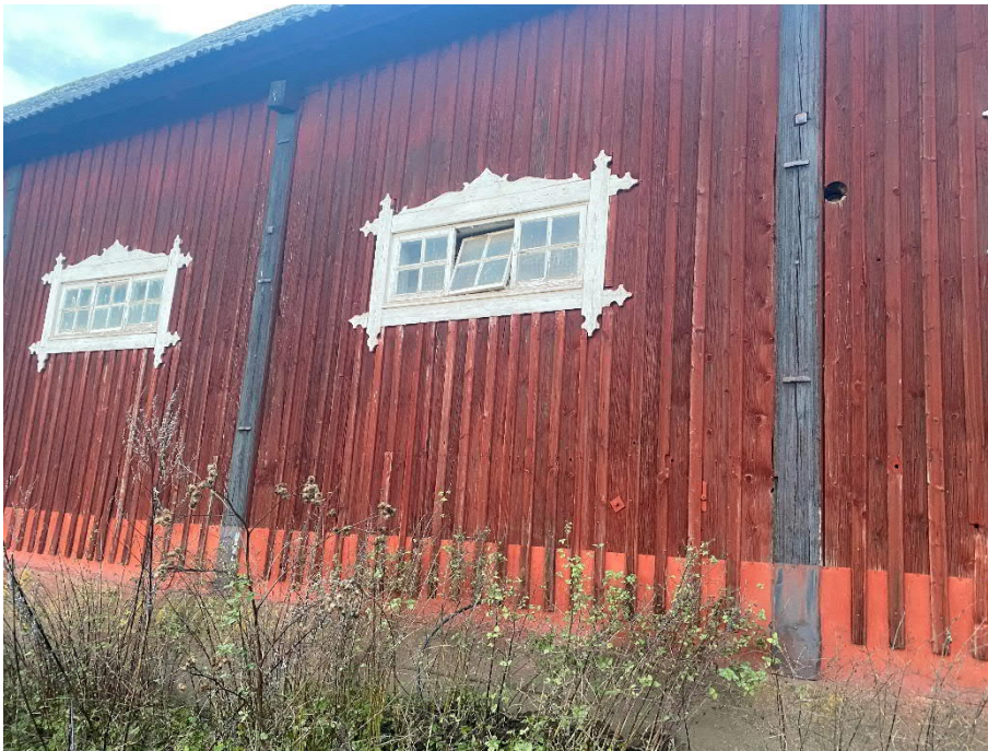
Bild 2 – Byggnad 1, fasad mot söder.
