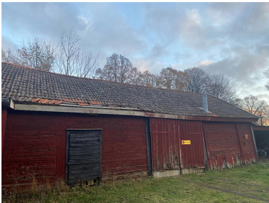
Bild 13 – Byggnad 4, fasad mot väster.
