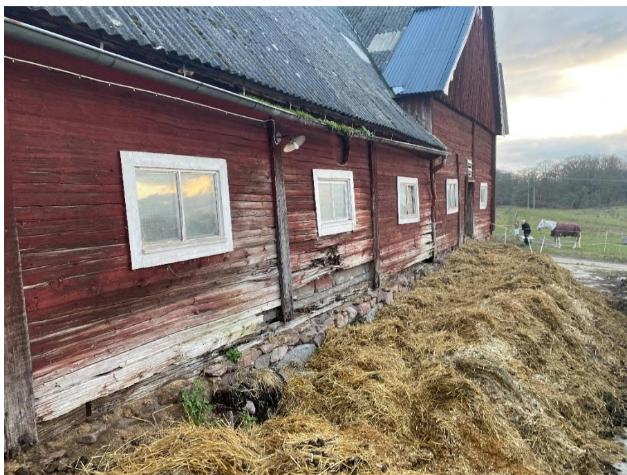
Bild 8 – Byggnad 2, fasad mot sydväst.
