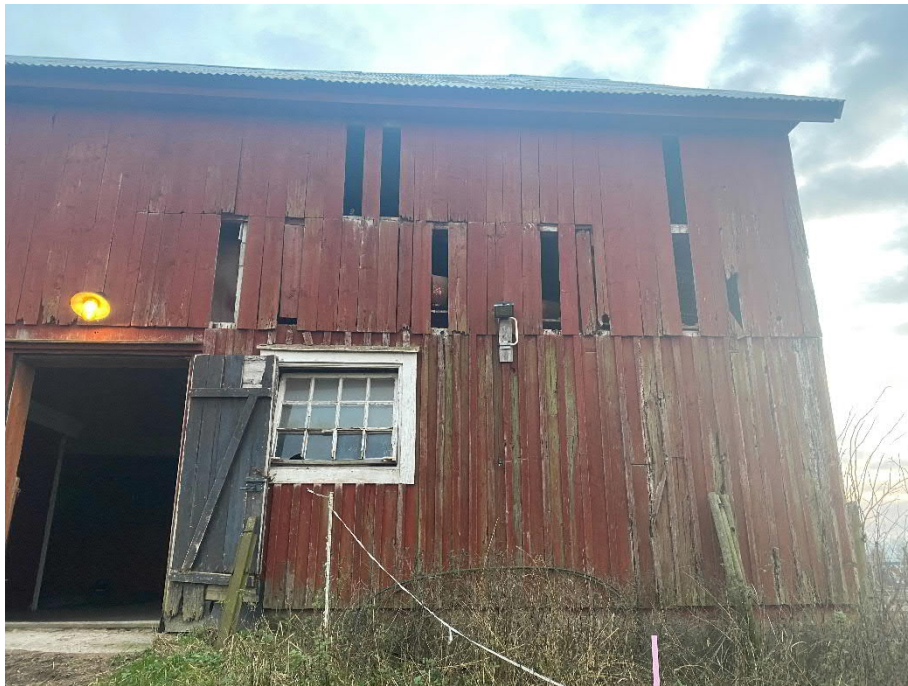
Bild 12 – Byggnad 3, fasad mot norr.
