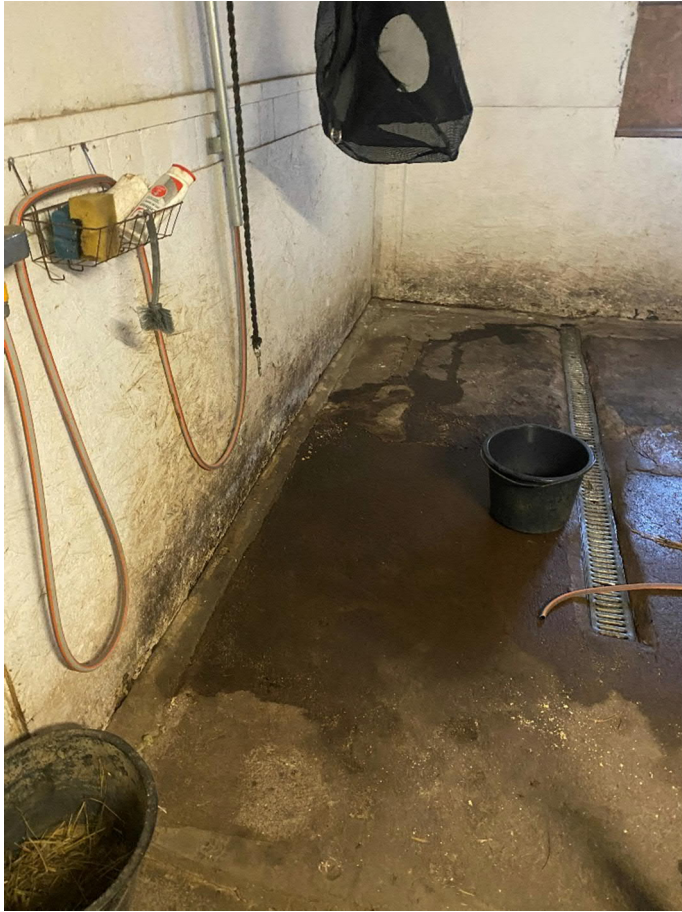
Bild 9 – Byggnad 2, fasad vid tvättdel.
