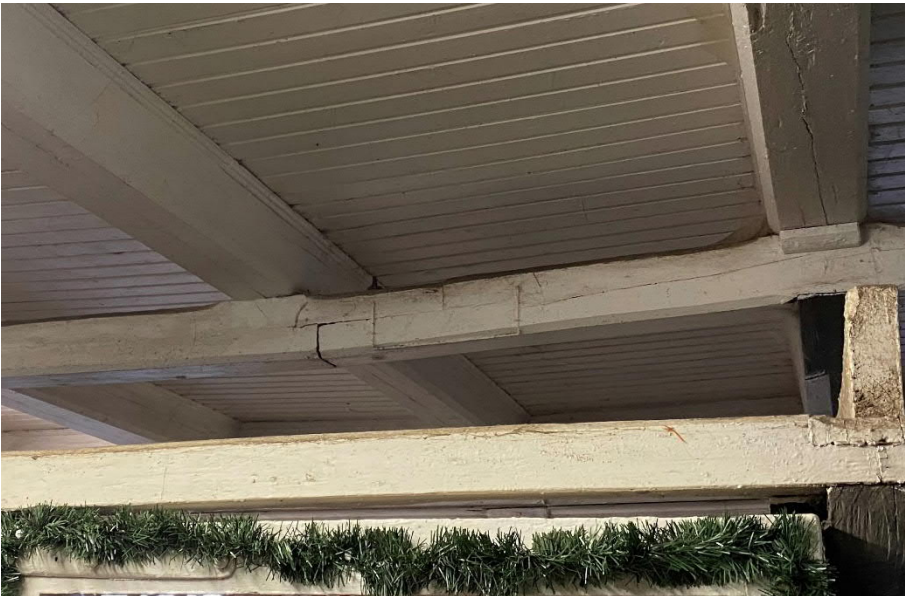
Bild 8 – Byggnad 1, balksskarv i pelarrad.
