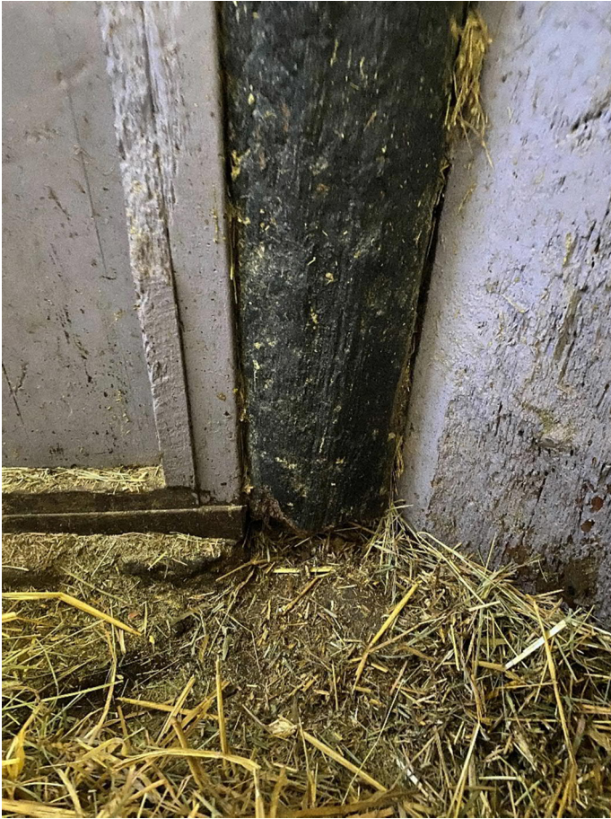
Bild 5 – Byggnad 1, pelare inomhus.
