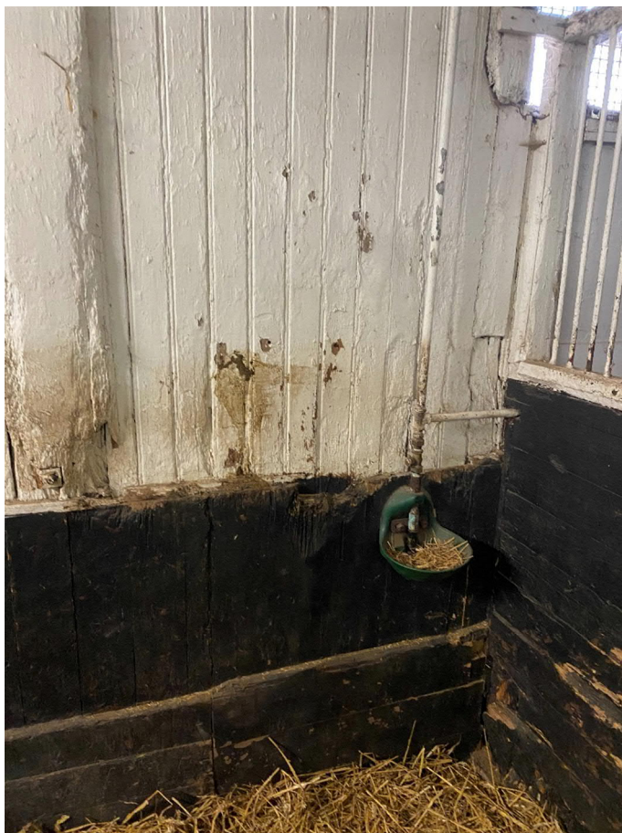
Bild 6 – Byggnad 1, insida fasad.
