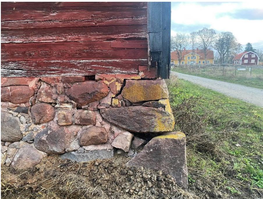
Bild 3 – Byggnad 1, stengrundläggning mot sydväst.
