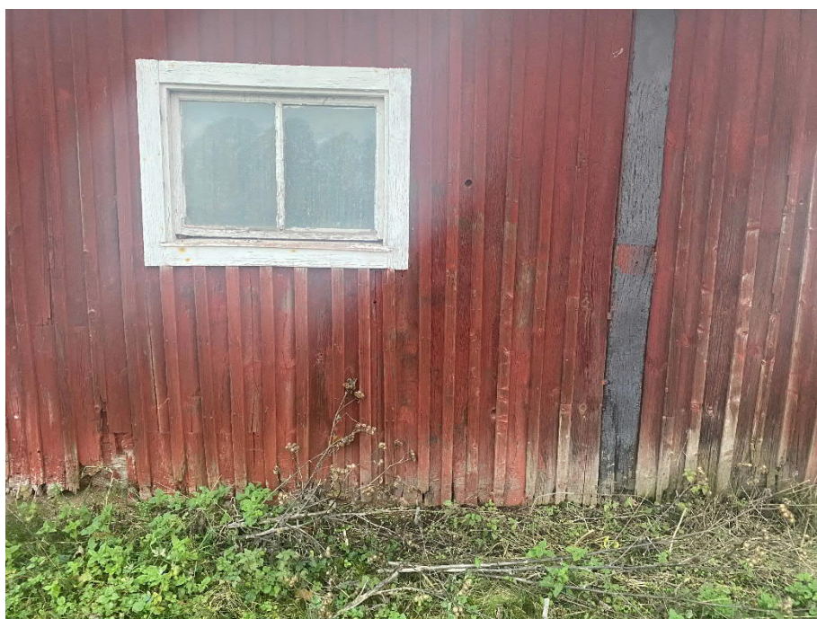
Bild 11 – Byggnad 2, fasad mot öster.
