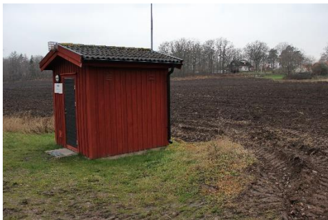
Pumphus strax invid Riksvägen (gamla E22).
