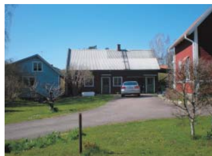
Komplementbyggnader (de två till vänster) placerade bakom huvudbyggnaden (till höger).
