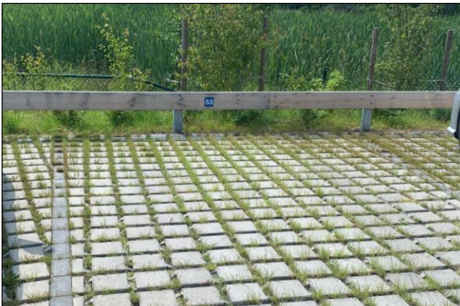
Figur 15. Genomsläppliga beläggningar. Bildkälla: Sweco
