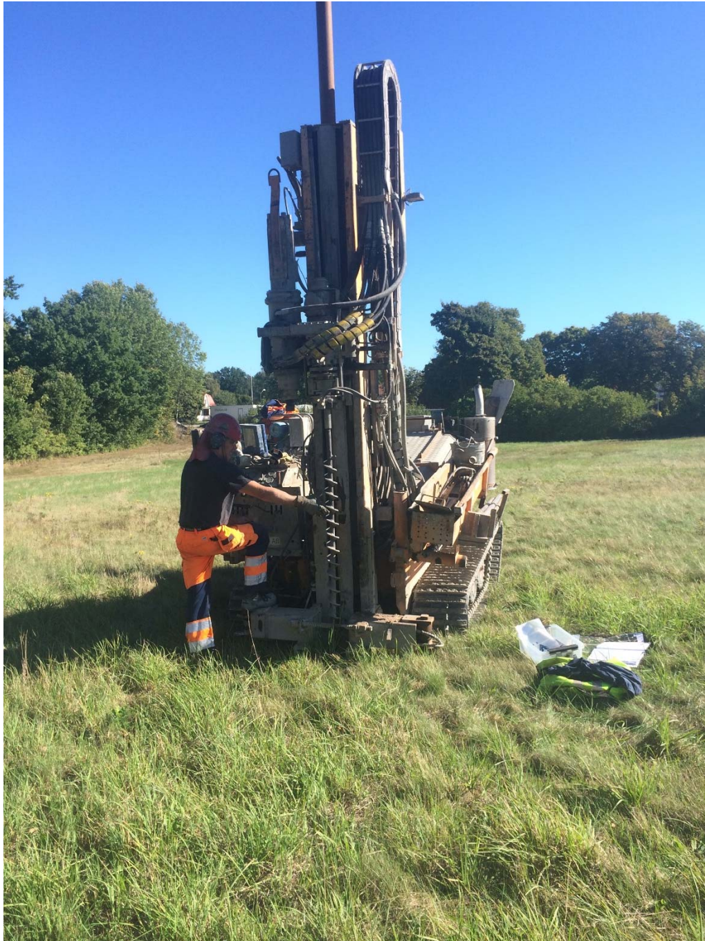
Figur 1 Borrbandvagn vid mätpunkt H5.
