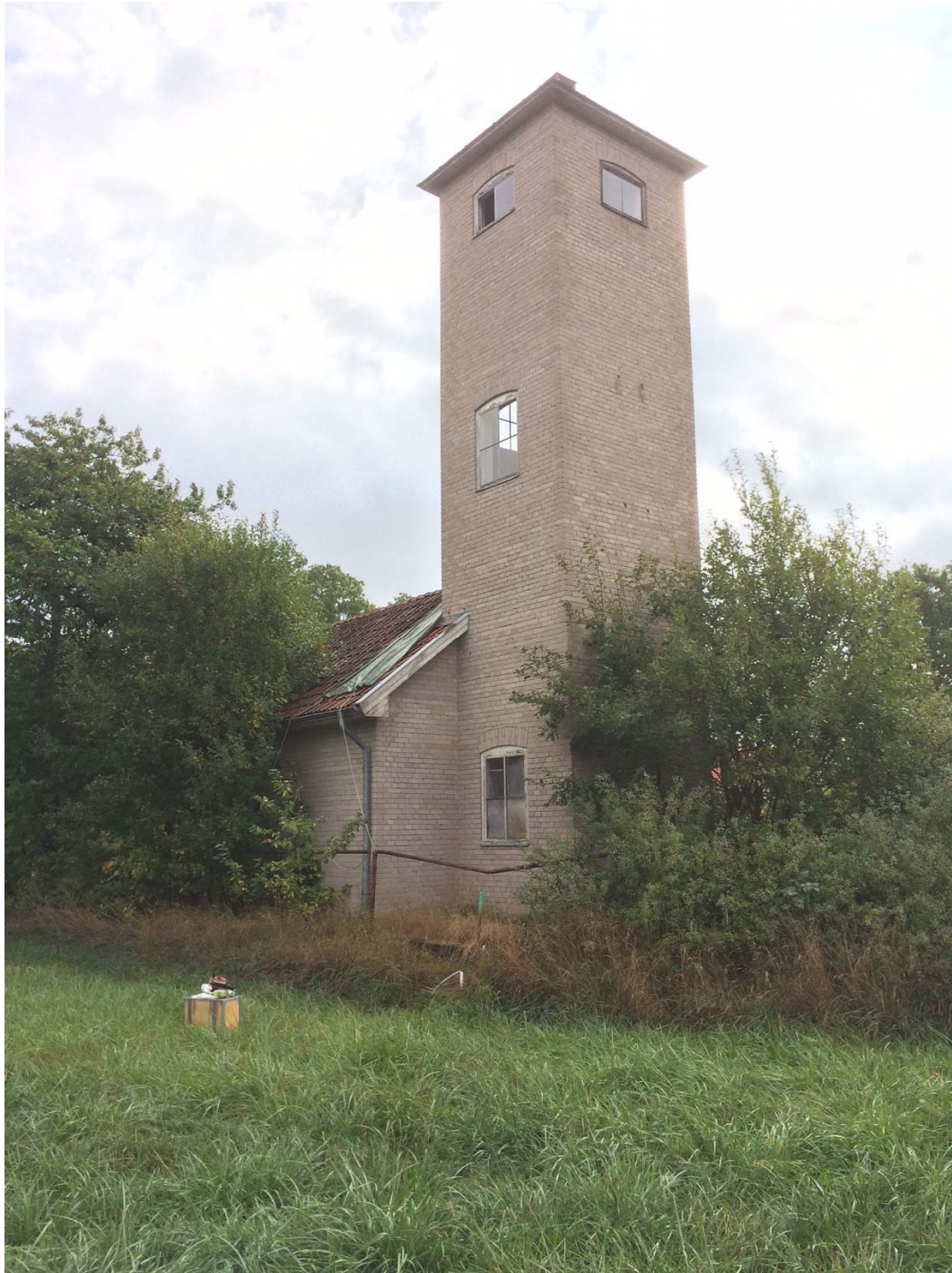
Figur 3 Grundvattenrör vid brandstation
