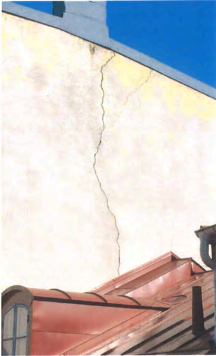
Ovan: Grannfastighetens gavelspets
