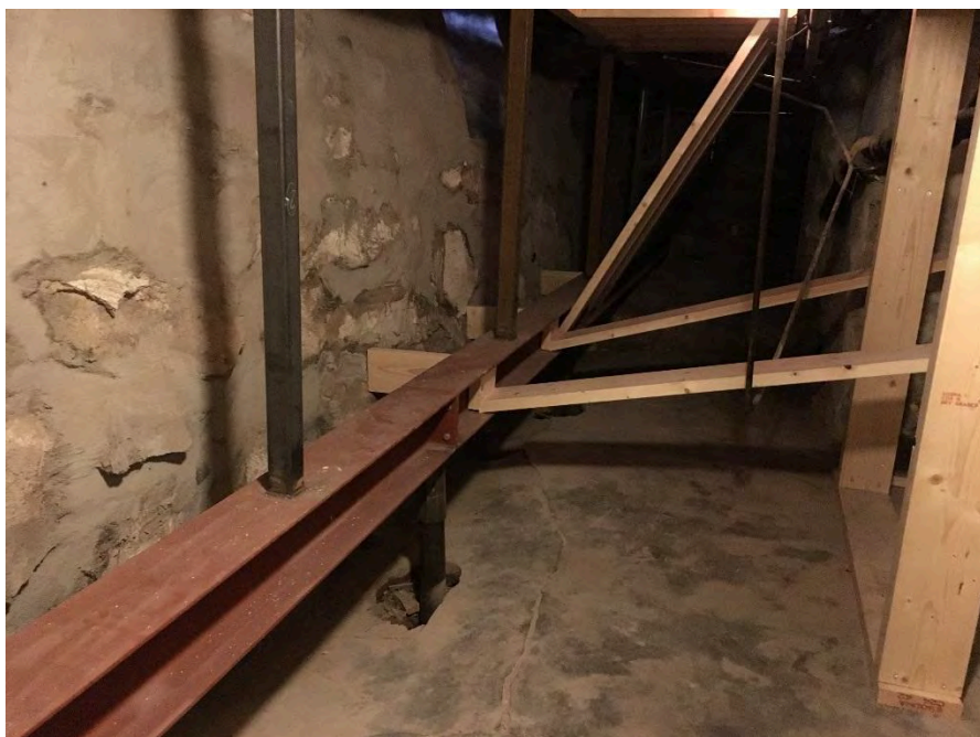
Figur 1 Bild som visar grundförstärkning som utförts med stålpålnar och avvåxlingsbalkar.
