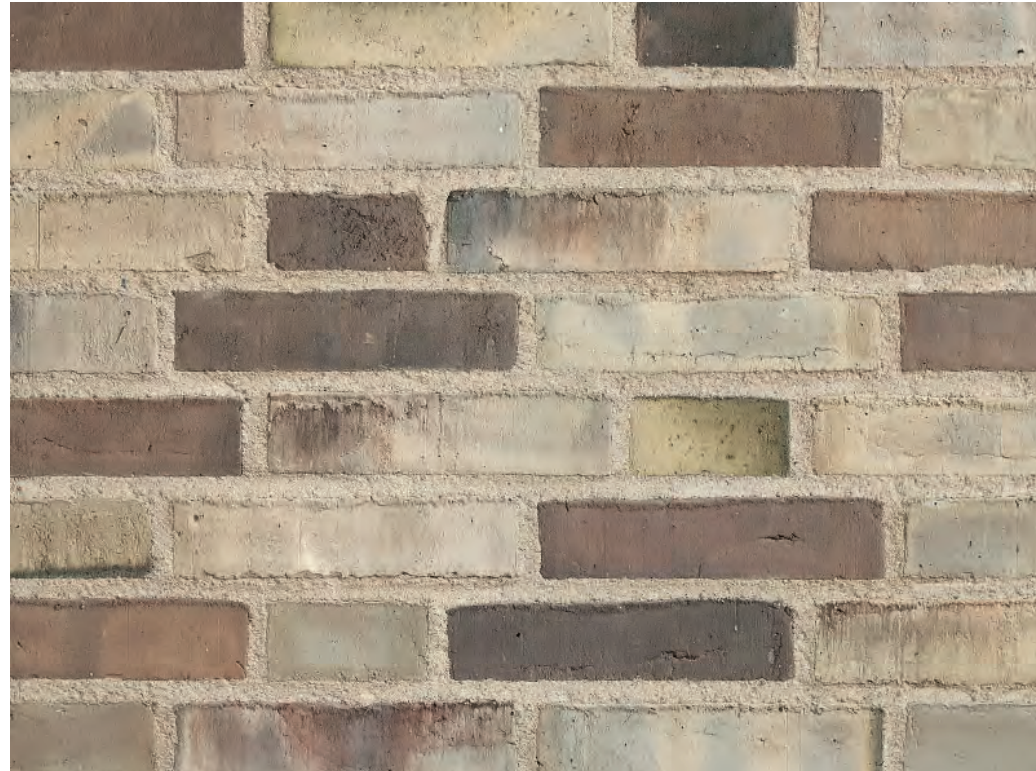
TEGEL BACHMANN, ROYAL DAWN, 228 x 108 x 54 mm, SLAGET TEGEL, KRYSSFÖRBAND
