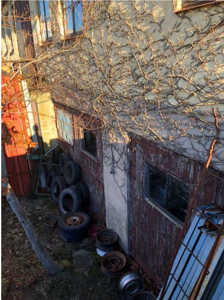
Dörrar vid källarnedfart mot väst.
