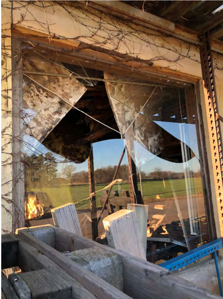
Fönster mot gata i öst.
