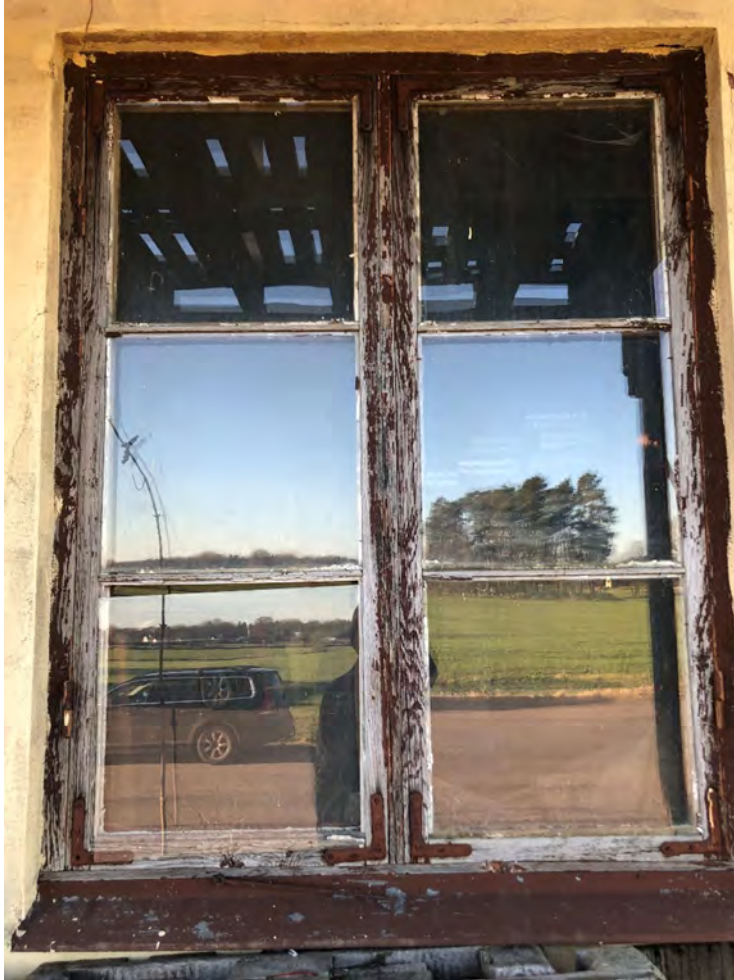
Fönster mot gata i öst.
