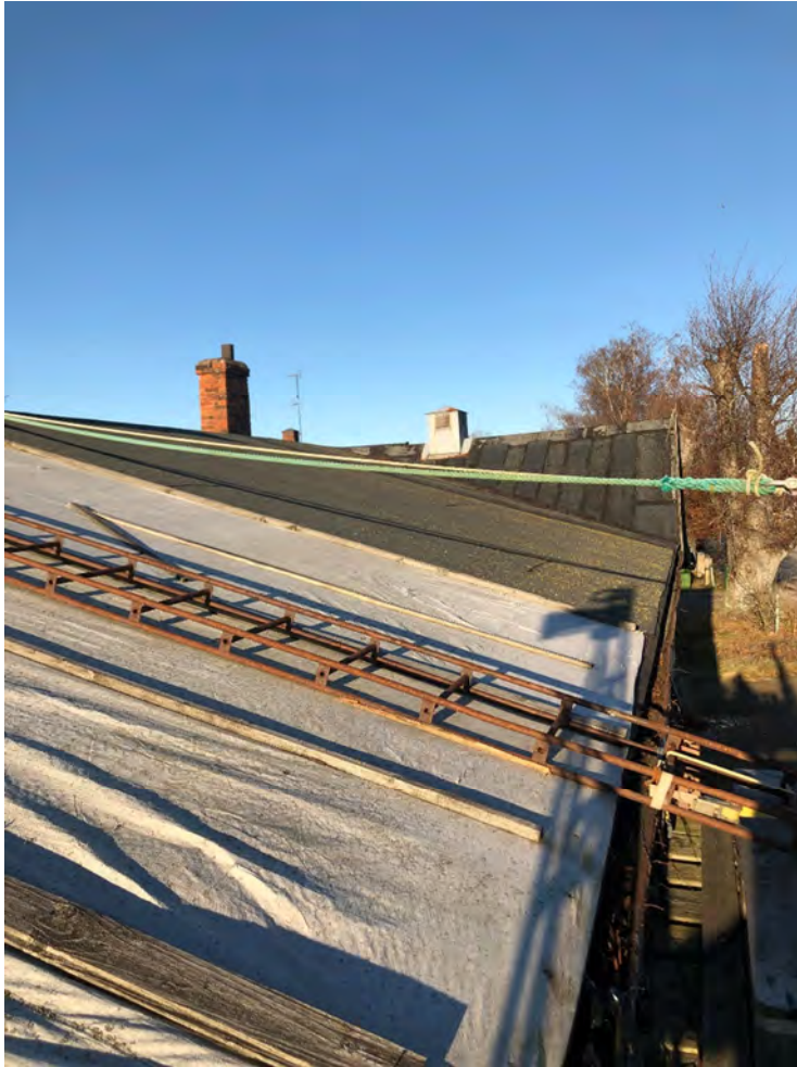
Presenning över takets sydöstra del.
