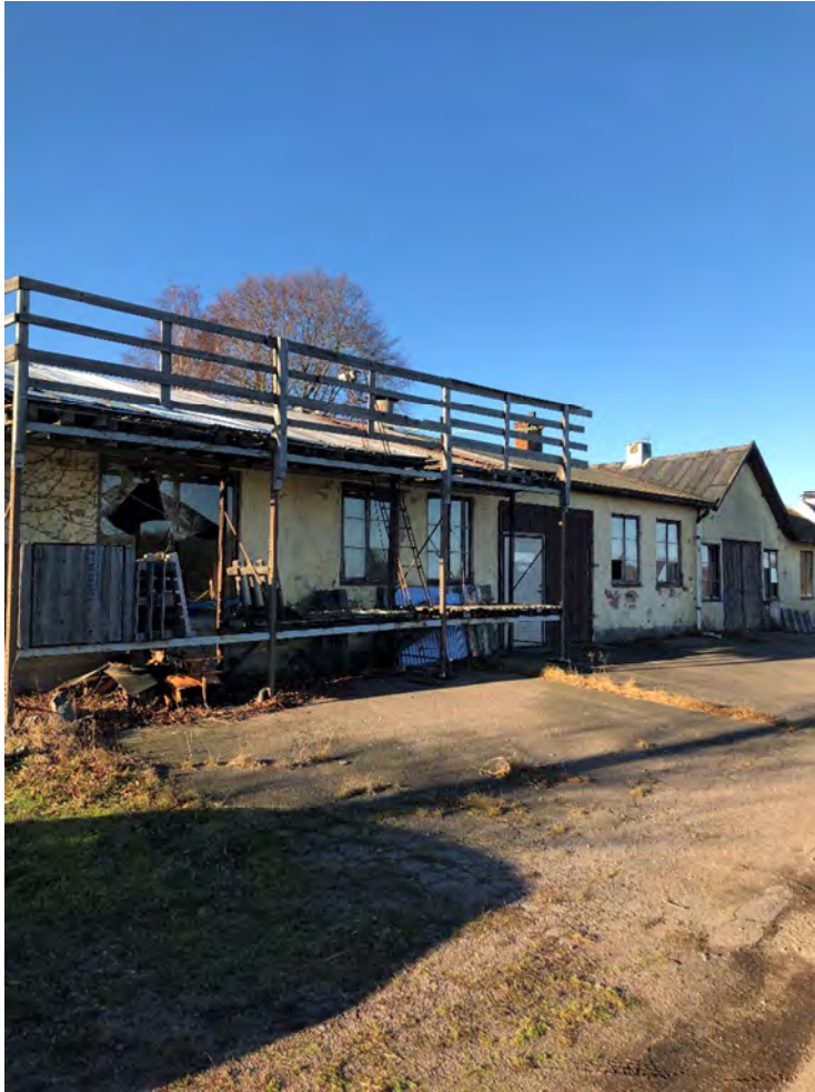
Fasad mot gata i öst.
