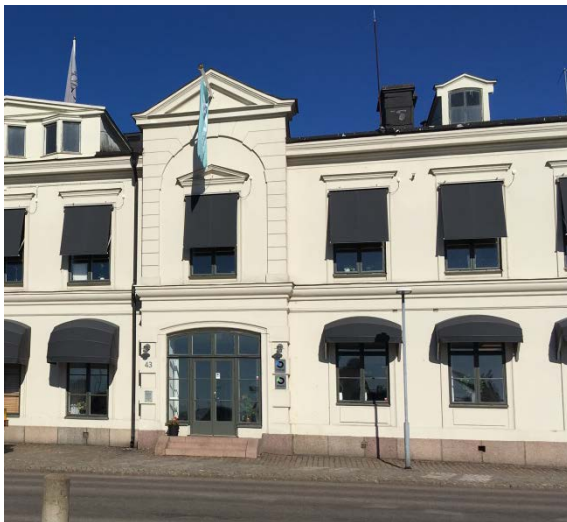
Bilden visar en av de framskjutande risaliterna på Tullhuset. En risalit är ett svagt framskjutande parti av en fasad genom byggnadens hela höjd.
