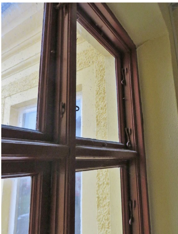
Bild 22. Enkelglasfönster med ursprungliga beslag i kökstrappan i byggnadens västra del.
