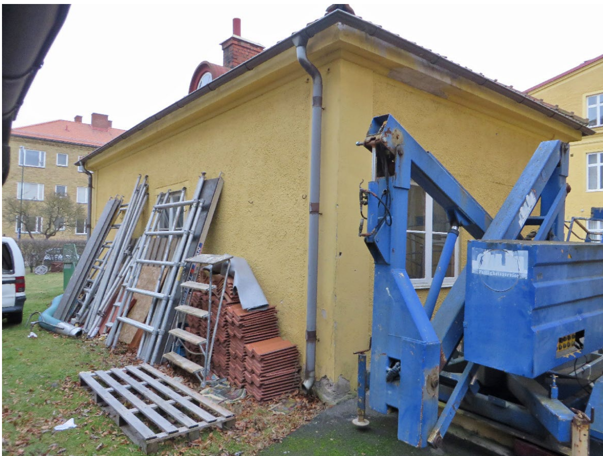
Bild 32. Uthusets norra och västra fasader.
