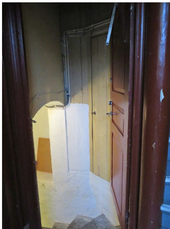
Bild 23. Källartrappan i kökstrapphuset i byggnadens västra del.
