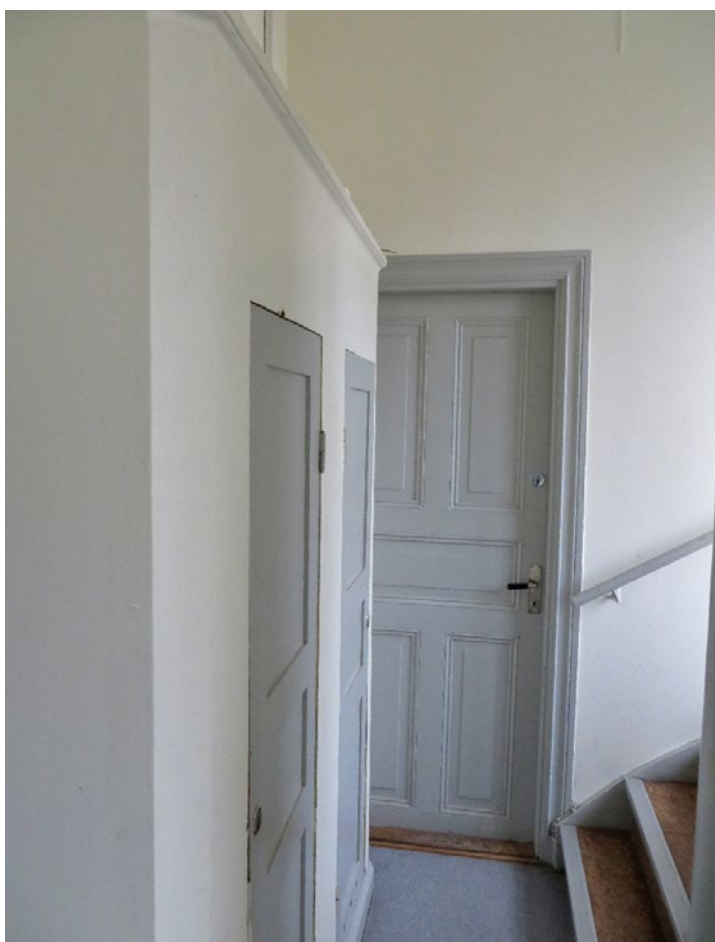
Bild 18. Originaldörrar och skafferiinredning i gathusets östra kökstrappa.
