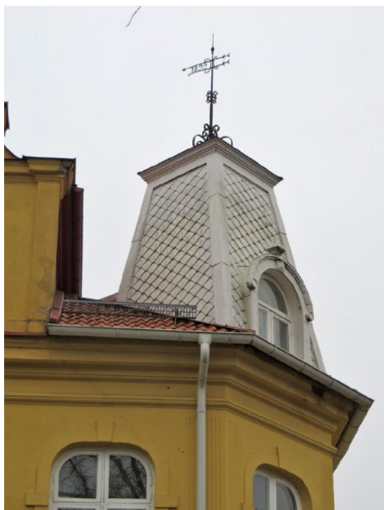
Bild 15. Den skifferimiterande takplåten på gathusets dekorativa hörntorn har relativt nyligen lagts om.
