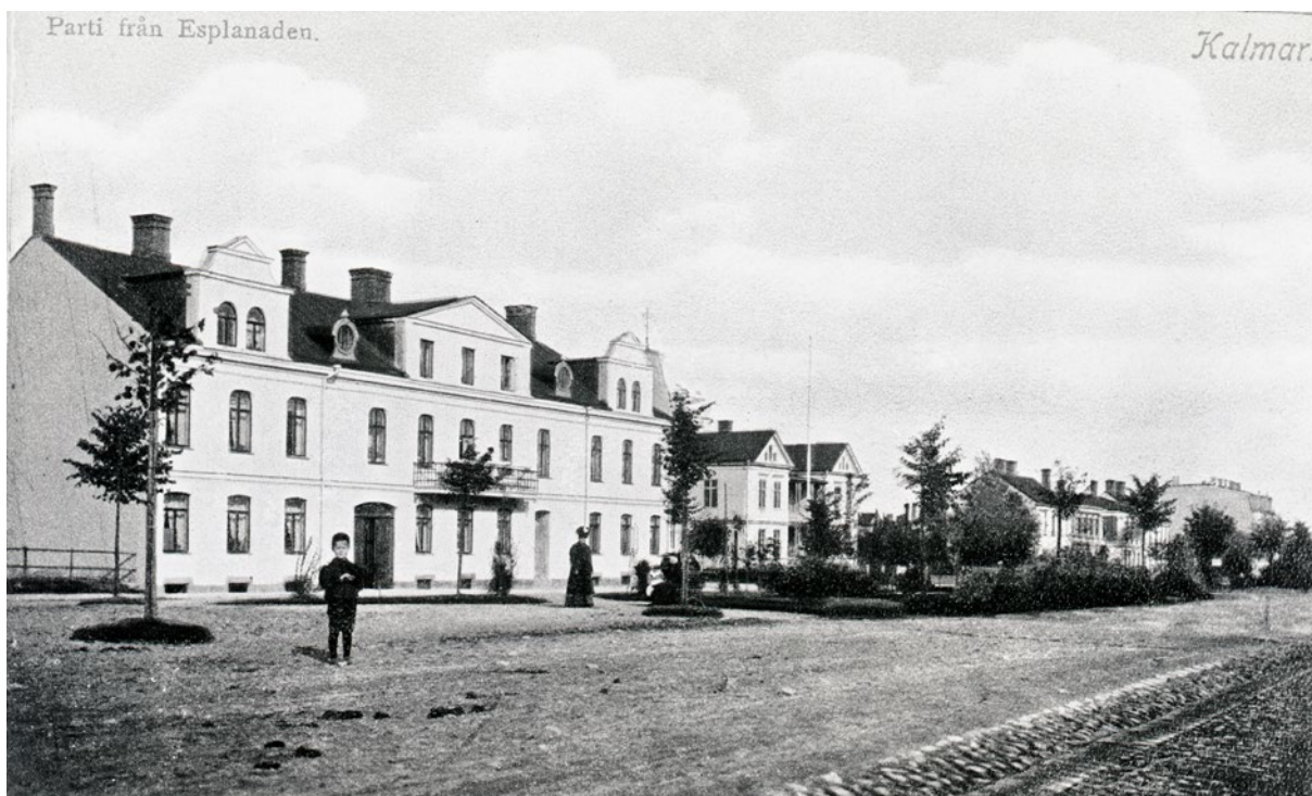
Bild 11. Odaterat vykort, ca 1910. Vy utmed Esplanaden med Falken 4 till vänster. Byggnaden är sig mycket lik, jämfört år 2017. Portgången som togs bort på 1950-talet syns på bilden, liksom den ursprungliga utformningen av de små takkuporna. Skorstenen närmast i bild finns inte heller kvar idag. (Ur Kalmar läns museums bildarkiv.)
