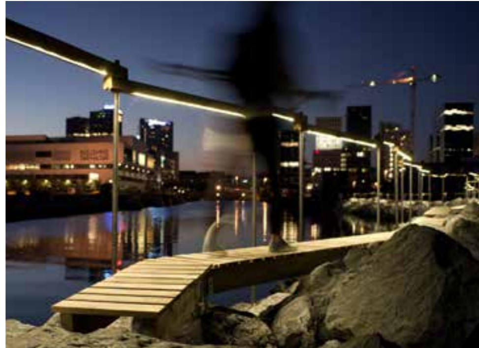
Integrerad belysning i ett räcke ger en fin markering av en gångväg längs vattnet. Det är viktigt att här tänka på att inte skapa oönskade speglingar i vattnet och om möjligt använda sig av en asymmetrisk ljusfördelning. Fotografi: Tomasz Malewski
