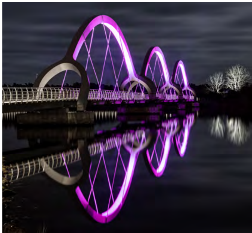
Jämn reflektion i vatten. Vatten kan skapa jämna spegellika reflektioner som förstärker upplevelsen av bron. Fotografi: ÅF Lighting
