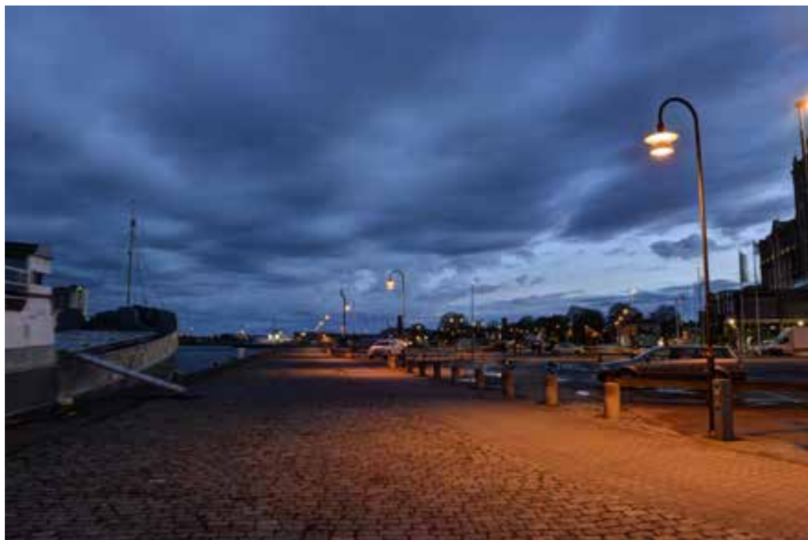
Elevatorkajen. Belysningen längs Elevatorkajen består mestadels av högtrycksnatrium. Om natten stör armaturerna med lysande armaturhus till viss del vyerna mot de vackra fasaderna. Fotografi: Jan Magnusson
