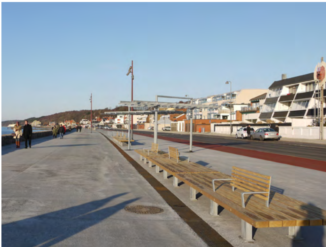
Helsingborg Strandpromenad. Belysning av en strandpromenad med gångareal och bilväg. All belysning är avskärmad och nedåtriktad för att de boende och de som färdas längs promenaden på kvällen ska kunna njuta av utsikten. I dagsljus harmonierar belysningsutrustningens uttryck fint med miljön. Fotografi: Kathrine Brand
