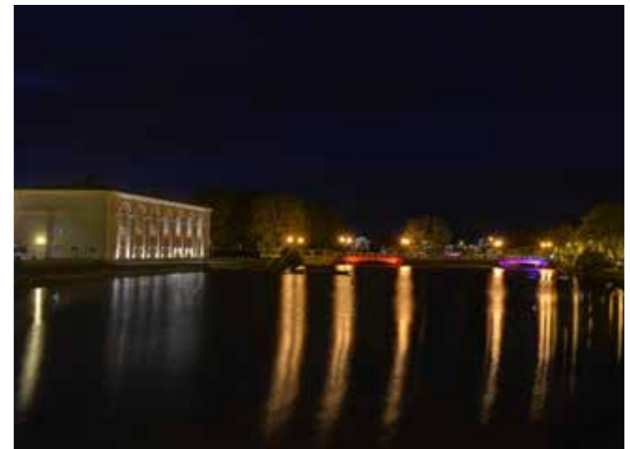
Fredriksskansbron och Stagneliuskolan. En bro i Kalmar med en belysningslösning som inte harmoniserar med miljön. Det omgivande grönrummet försvinner i mörkret vilket är ett vackert inslag i dagsljus. Belysning på bron skapar för stora kontraster och vatten rummet blir inte tydligt definierat. Fotografi: ÅF Lighting och Jan Magnusson
