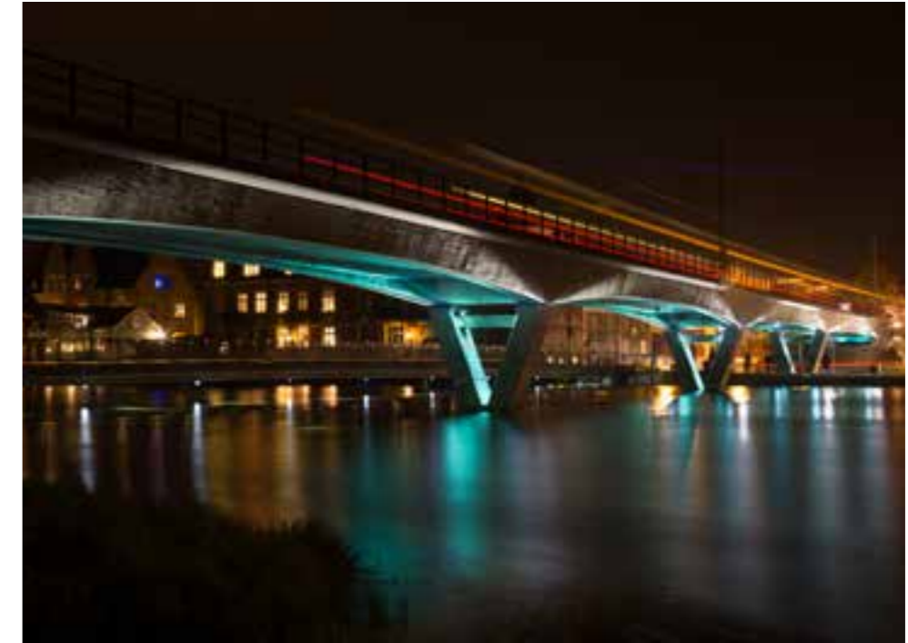
Vattenbron i Eskilstuna. En vackert ljussatt bro med integrerad belysning skapar både ett landmärke, ett vackert inslag i stadsrummet och ökar tryggheten under de mörka timmarna. En belyst bro skapar en tydlig förbindelse i nattstaden. Fotografi: Sten Jansin
