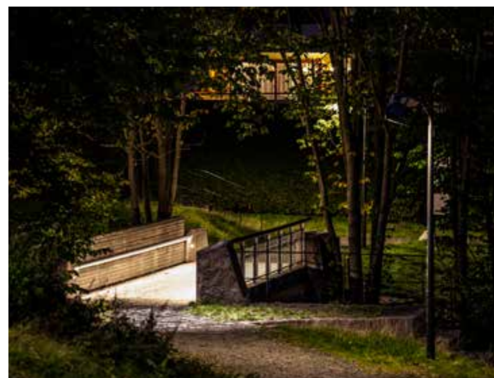
Grorudparken, Norge. Integrerad belysning i broräcke lyser effektivt upp en bro i parken. Fotografi: Tomasz Majewski
