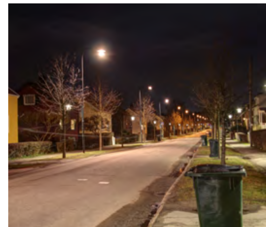
Färgåtergivning, metallhalogen. Metallhalogen har generellt en hög färgåtergivning vilket framhäver detaljer och kontraster i gatumiljön. Detta är att föredra ur en säkerhetsaspekt vid planering av vägbelysning.
