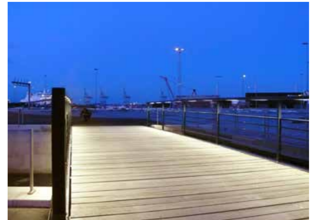
Bro i Aarhus, Danmark. Belysning integrerad i räcket ger gång- och cykelbron ett fin allmänbelysning samtidigt som bron framhävs på ett enkelt sätt utan att störa en eventuell utsikt. Fotografi: ÅF Lighting
