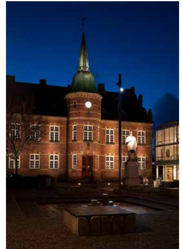
Silkeborg Rådhus, Danmark. En enkel fasadbelysning som synliggör byggnaden. Här är inte hela taket belyst utan bara tornet. Att belysa tornet gör mycket för intrycket av byggnaden. Fotografi: ÅF Lighting
