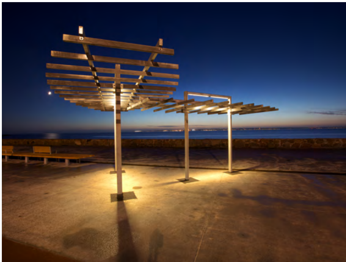
Helsingborgs strandpromenad Integrerad, avskärmd och nedåtriktad belysning i pergola bidrar till ett stämningsfullt ljus och skapar attraktiva mötesplatser samtidigt som att den ostörda utsikten över vattnet bevaras.
