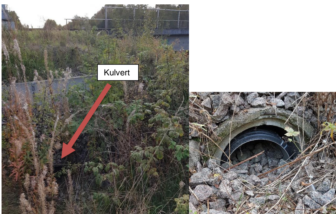
Figur 3: Kulverten och dess läge i förhållande till kringliggande mark.
