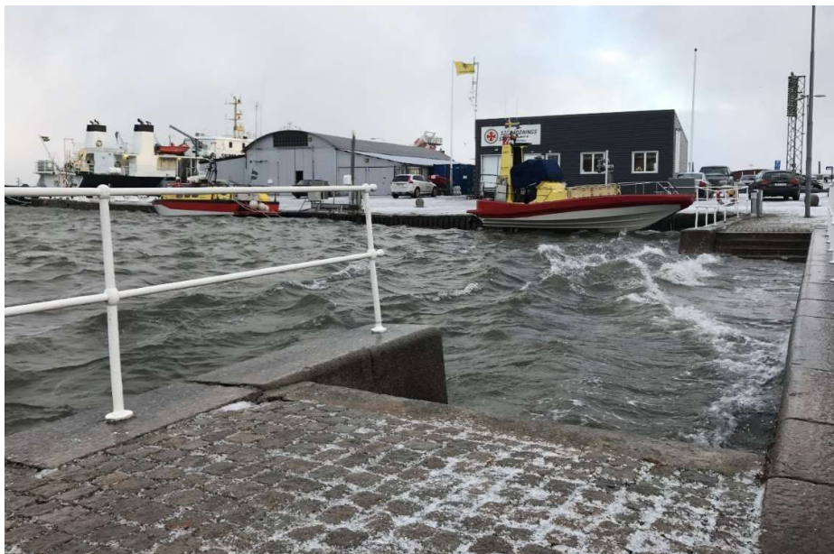
Högvatten vid Elevatorkajen i januari 2017 Foto: Elena Bäcklund
