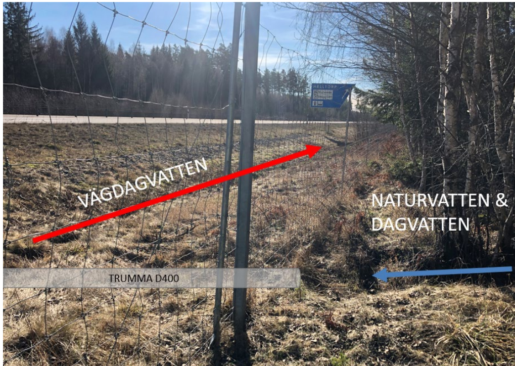
Figur 13. vägdike och anslutande mindre dike, vid trumma 2, med rinnpilar
