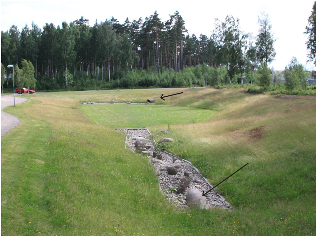
Figur 19. Exempel på torr damm. Pilar visar in- och utlopp
