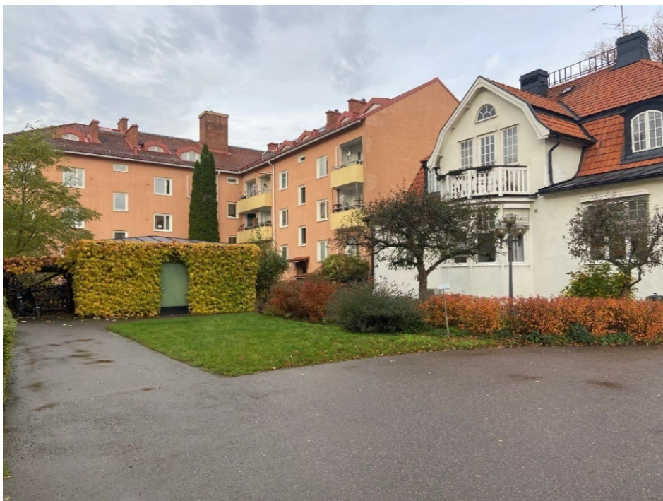
Planområdet sett från innergårdens östra hörn, mot gårdshus och tandläkarvillan. Bakom planteringen finns uteplatsen.
