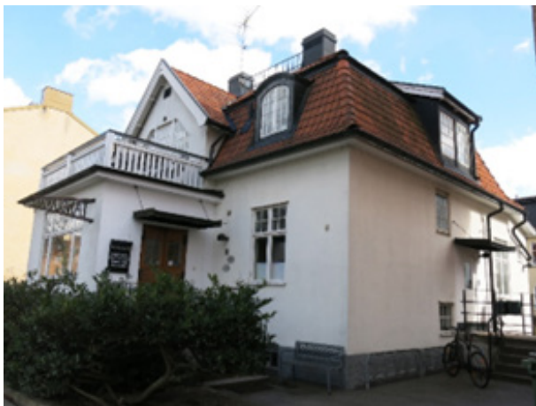
Villan från nordväst med ursprunglig huvudentré respektive köksingång. Foto: Byggkult 2022.
