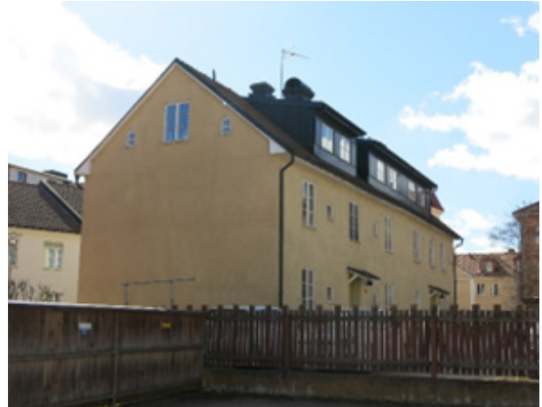
Byggnaden sedd från grannfastigheten i öster. Foto: Byggkult 2022
