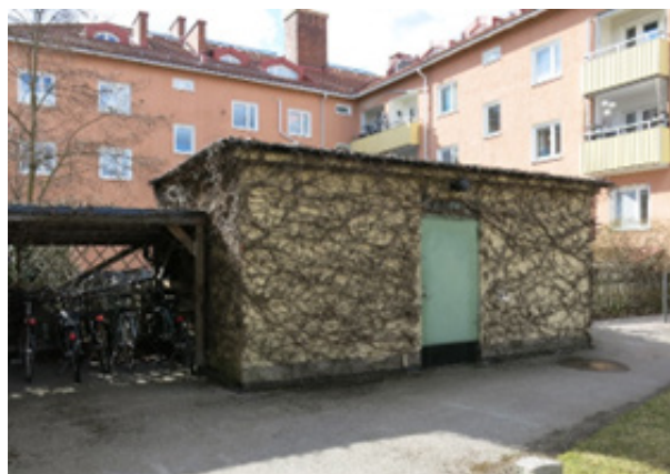
Garaget från gårdssidan med dörr från 1980-talet. Foto: Byggkult 2022.
