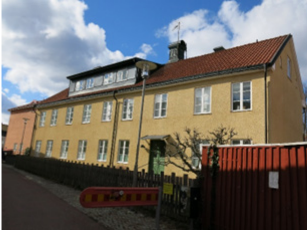
Flerbostadshusets långa fasad mot Spikgatan. Foto: Byggkult 2022
