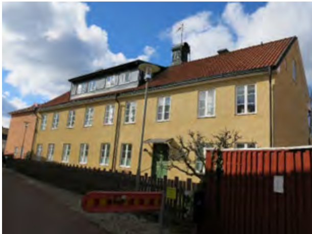
Flerbostadshusets långa fasad mot Spikgatan. Foto: Byggkult 2022
