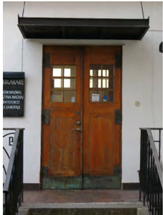
Entrépardörren med tidstypiska detaljer. Foto: Byggkult 2022.
