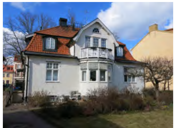
Gårdsfasaden med trädgårdsyta. Foto: Byggkult 2022.
