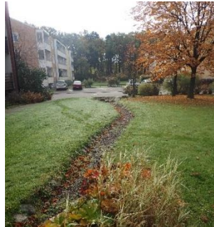
Lågstråk med dike för infiltration
