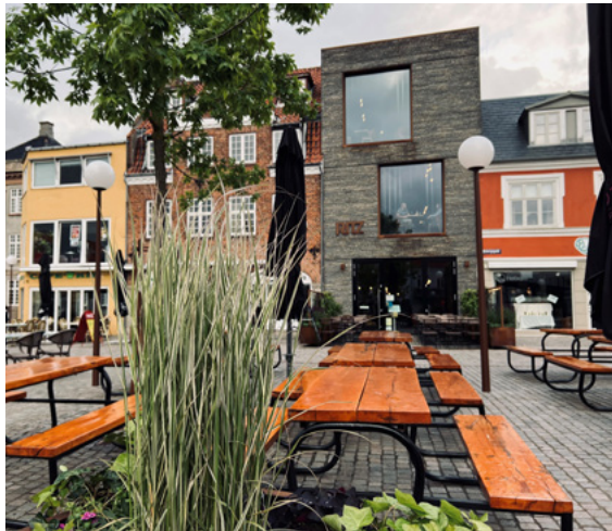
Den äldre bebyggelsen i Köpenhamn har kompletterats med en ny byggnad med ett modernare uttryck.
