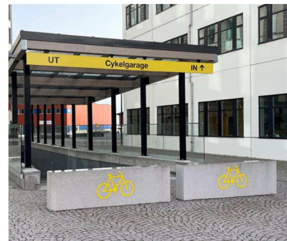
Ner- och uppfarten till cykelgaraget vid Linnéuniversitetet har en central placering och tydlig utformning.
