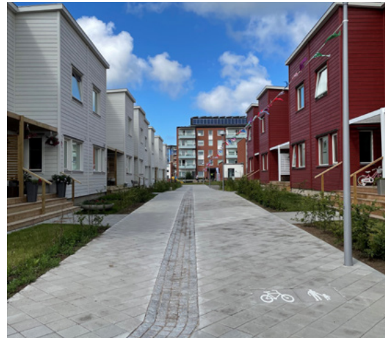
De nya radhusen i Drottninghög i Helsingborg har entréer mot det enhetligt utformade gång- och cykelstråket.
