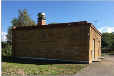
Befintlig pumpstation inom planområdet
