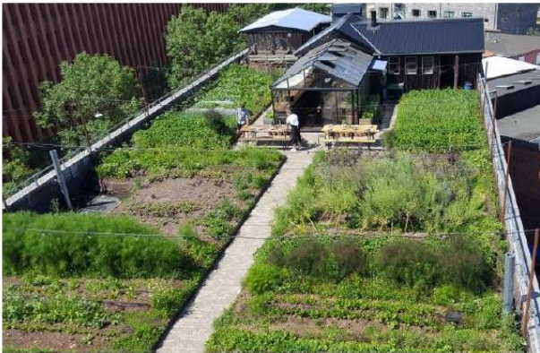
Figur 14. I Östergro bedrivs grönsaksodling och restaurang på ett före detta parkeringstak.
