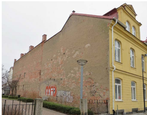
Gårdshuset är uppfört i ett så kallat halvhus med en hög brandmur mot grannfastigheten i väst. (Kalmar läns museum, Lotta Lamke.)
