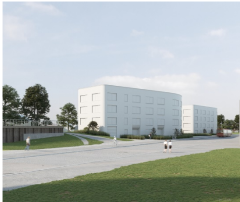
Vy från östra sidan Stensbergsvägen mot väster i höjd med Bragegatan
